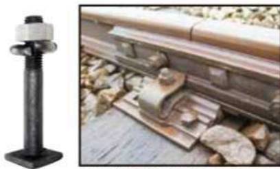
Instalación con tuercas normales
